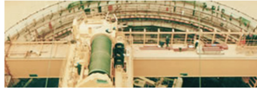
신고리 원자력 1, 2호기 POLAR CRANE용 TROLLEY 보수공사 발주처 : Westinghouse Electric Company(EDERER) 위 치 : 한수원(주) 고리원자력본부
