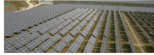
김천 태양광 발전소 건설공사 발주처 : 삼성C&T 위 치 : 경상북도 김천시
