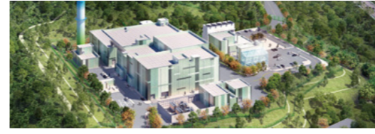
수출형 소형연구로 건설 공조설비 제작 설치공사 발주처 : KAERI / 대우E&C 위 치 : 부산시 기장군
