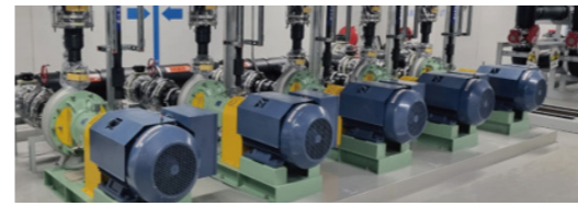
삼성전자 P2-PJT 대기방지(일반배관공사 PH-1) 발주처 : 삼성E&A 위 치 : 평택 고덕 삼성전자
