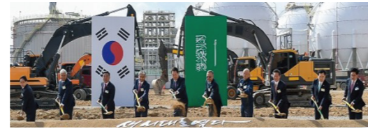
울산 사한 프로젝트 배관공사 발주처 : S-OIL / 현대E&C 위 치 : 울산 온산국가산업단지 내 S-OIL 부지
