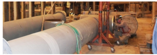
고리 원자력 3,4호기 해수배관 제작 / 설치공사 발주처 : 한수원(주) 위 치 : 한수원(주) 고리원자력본부
