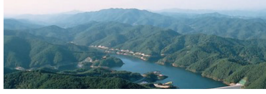
청송 양수 1,2호기 발전소 터빈 조립공사 발주처 : GE-II 위 치 : 경상북도 청송군
