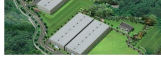
중저준위 방사성폐기물 처분시설 2단계 공사 발주처 : KORAD / 대우E&C 위 치 : 한수원(주) 월성원자력본부
